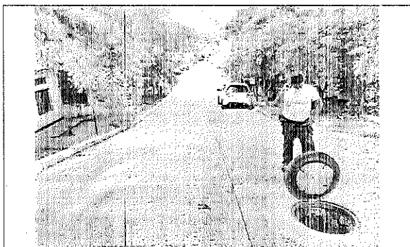
21. Destape y revisión de pozos
